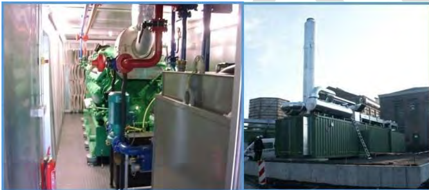
სურათი 20 კომპაქტური მობილური თბოელექტროსადგური
